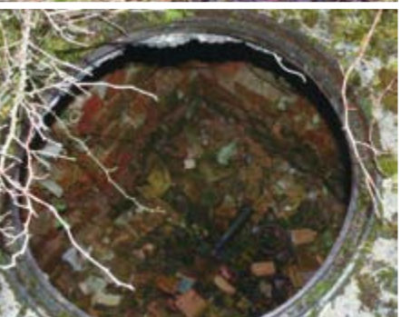
Exkursion zum ehemaligen Truppenübungsplatz, Begutachtung von Überresten der alten Drainageanlagen.
